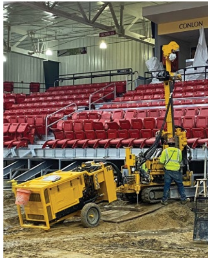
DRILLING HOLES TO POUR CONCRETE PILINGS
